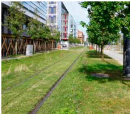
Aanleggen van spoorlijnvergroening met gras
